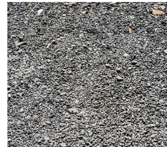
Photographie 71 : texture des pistes en concassé granit.
