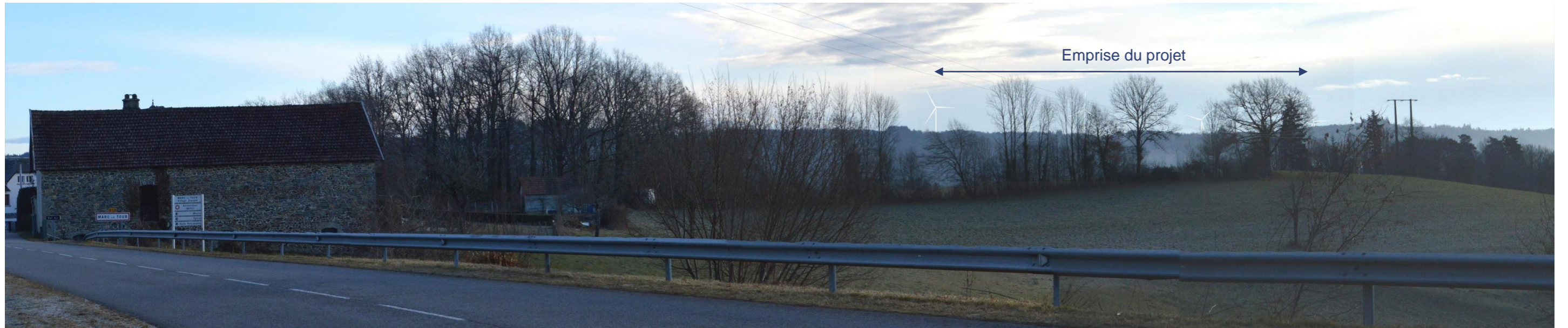
Photographie 84 : Visibilité filtrée par la végétation le long de la D10 à l'ouest de Marc-la-Tour (PM n°9).
