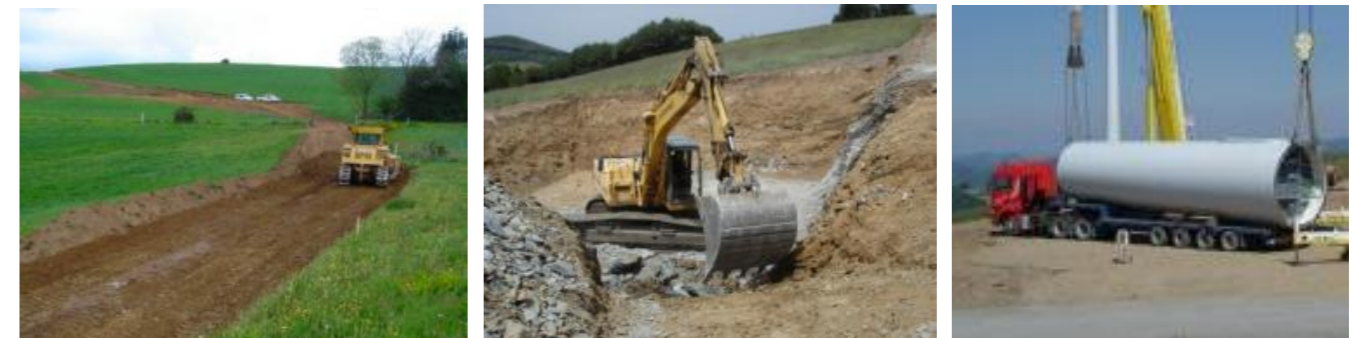
Photographie 74 : illustration d'un chantier éolien
