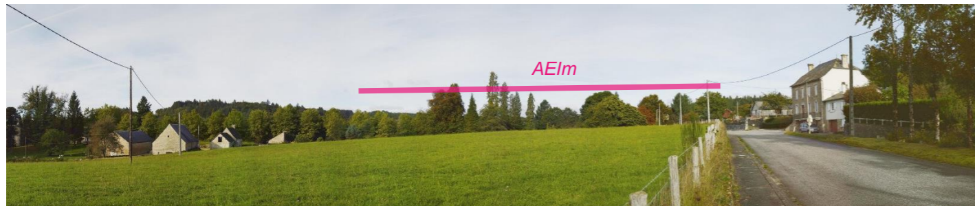
Photographie 54 : Vue depuis la D131 à La-Roche-Haute.
